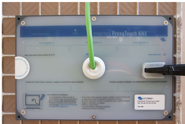
Abbildung 3: Fixierung des Gehäuses
