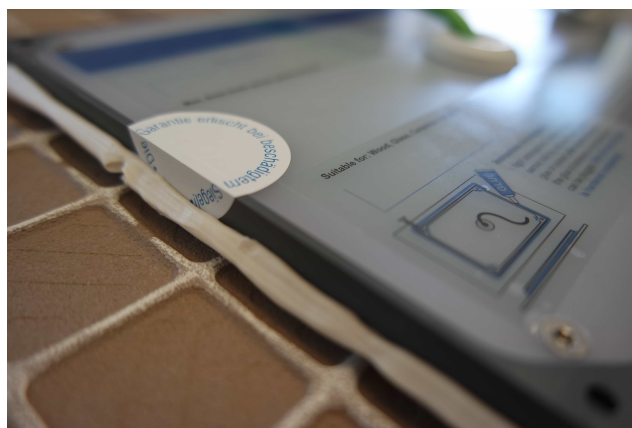
Abbildung 4: Auftragen des Montageklebers
