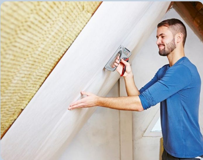
Folie beim Dachbodenausbau einfach befestigen.
